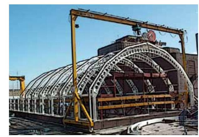
L'ossature est faite de métal, le plus souvent d'acier. C'est le support sur lequel viendront se poser les plaques de verre.
